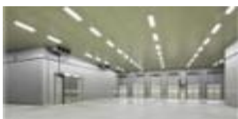
コールドチェーン確保のための冷蔵設備
